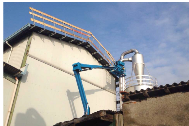
6. Montaggio parapetti con PLE
