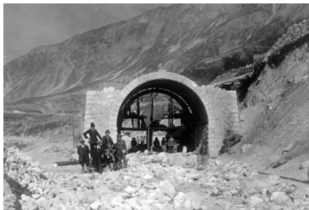
Vittorio Veneto, lavori di costruzione della ferrovia Vittorio Veneto Ponte nelle Alpi
