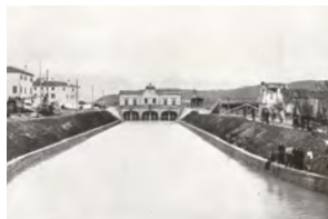
Nervesa della Battaglia – Edificio di presa e primo tratto del Canale della Vittoria
