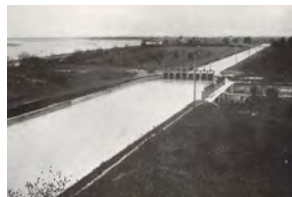
Canale della Vittoria – Tripartitore fra i 3 canali principali: Priula, Pievesella e di Ponente
