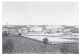
Fase di costruzione del nuovo Mercato, oggi odierno centro di Montebelluna
