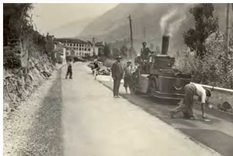
Pavimentazione stradale con asfalto Sintex, anni 40
