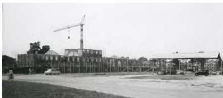
1990 ca. Lavori di ristrutturazione del complesso architettonico
